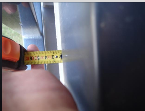
Fot. 19 . Miejscowe nieprawidłowości w wielkości kapinusu obróbki blacharskiej. Tu 18mm (powinno być min 30mm)
