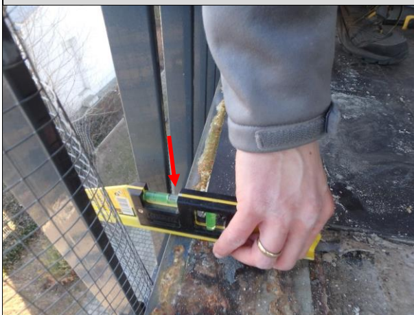
Fot. 04_7. Spadek obróbek blacharskich w kierunku „od budynku” – prawidłowo. Czerwoną strzałką wskazano położenie oczka libelli.
