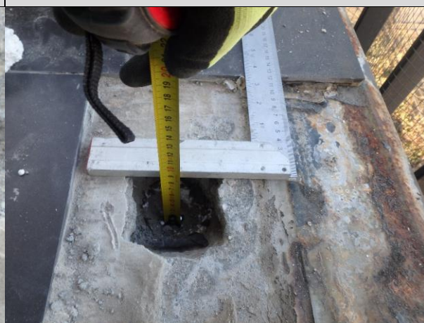
Fot. 04_12. Łączna grubość warstw posadzkowych 9cm.
