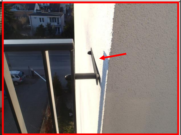
Fot. 48, 49. Miejscowa niestabilność zakotwienia balustrady.
