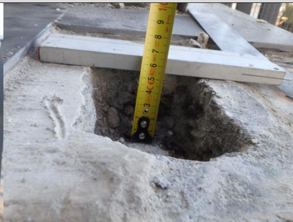
Fot. 04_10. Zmierzona grubość szlichty 5,5cm.
