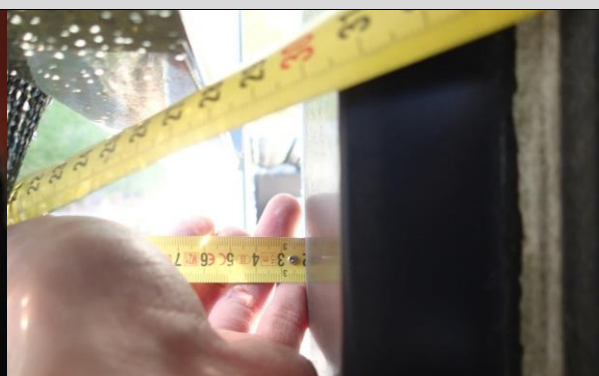
Fot. 13. Miejscowe nieprawidłowości w wielkości kapinosu obróbki blacharskiej. Tu 20mm (powinno być min 30mm)
