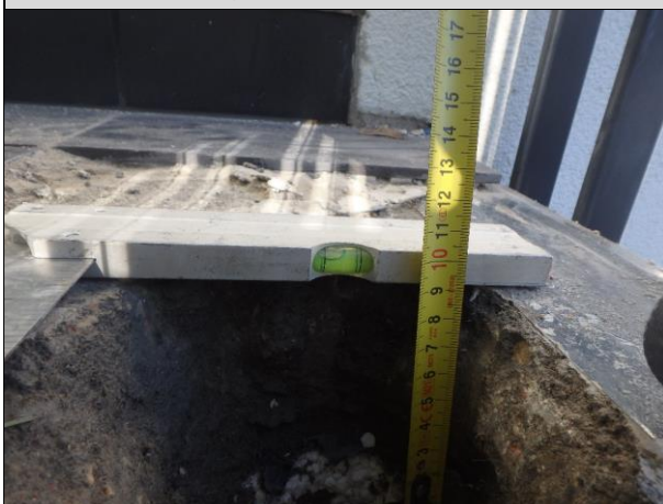
Fot. 03_17. Zmierzona grubość szlichty 9cm .
