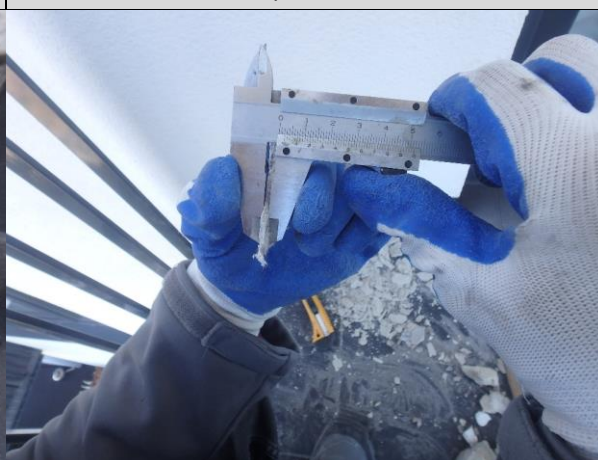
Fot. 02_8. Zmierzona grubość izolacji podpłytkowej ok 2,4mm – prawidłowo.
