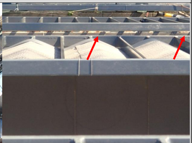
Fot. 45, 46. Korozja obróbek blacharskich balkonów sąsiadujących z lokalem nr 55.
