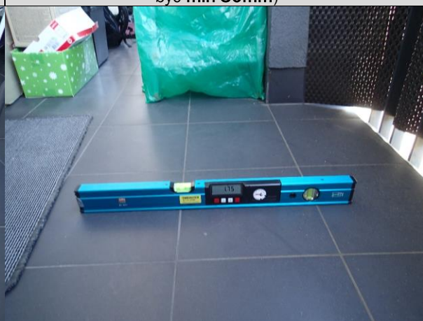
Fot. 20, 22 . Zmierzona wartość spadku od 0,87% do 1,75% , tj. miejscowo poniżej wartości projektowanej w wymiarze 1%.
