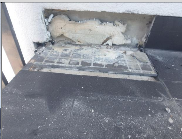
Fot. 02_5. Płytką cokołową klejona na placki. Grubość placka ok 1cm .
