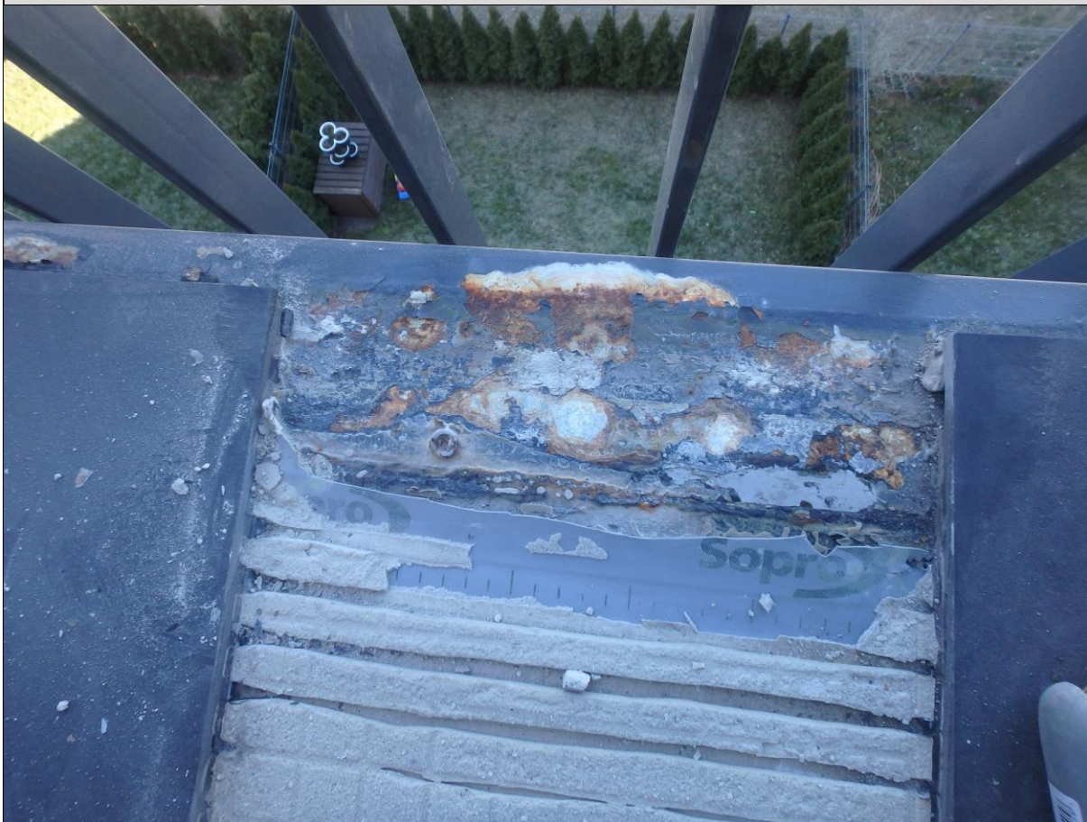
Fot. 01_10. Pod płytką stwierdzona zawansowana korozja obróbki blacharskiej – znacznie większa niż ta obserwowana na widocznej krawędzi okapu.
