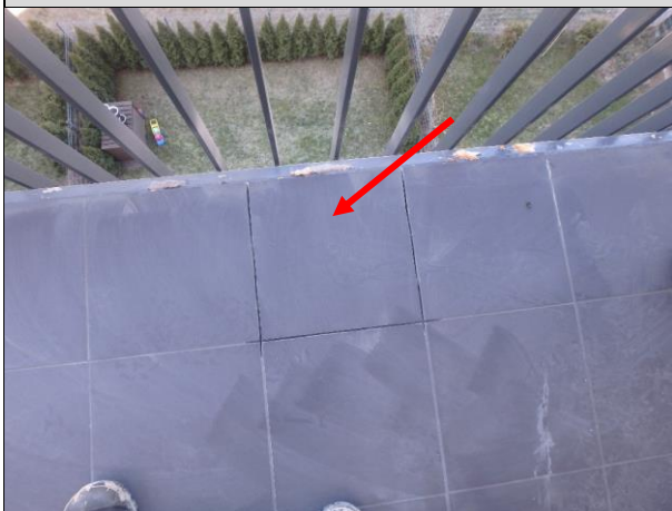
Fot. 01_2. Miejsce wykonania odkrywki – przy skorodowanej obróbce blacharskiej.
