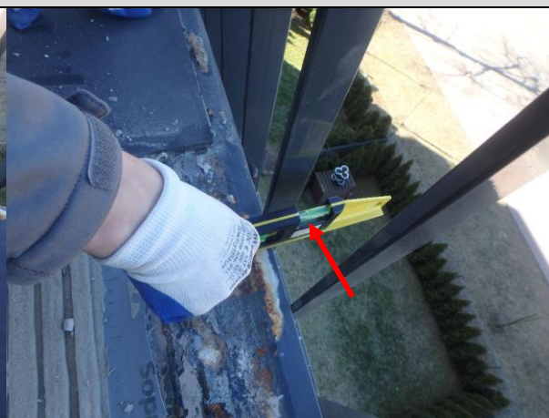
Fot. 01_11 (kadr). globalny spadek obróbek blacharskich w kierunku „od budynku” – prawidłowo. Czerwoną strzałką wskazano położenie oczka libelli.
