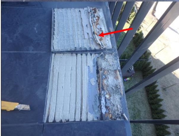
Fot. 01_4, 01_5, 01_6, 01_9. Nieprawidłowe wklejenie taśm izolacyjnych – taśma zamiast do obróbki została przyklejona do płytki – nieprawidłowo. Tak ukształtowana taśma utrudnia odpływ wody z poziomu izolacji podpłytkowej.
