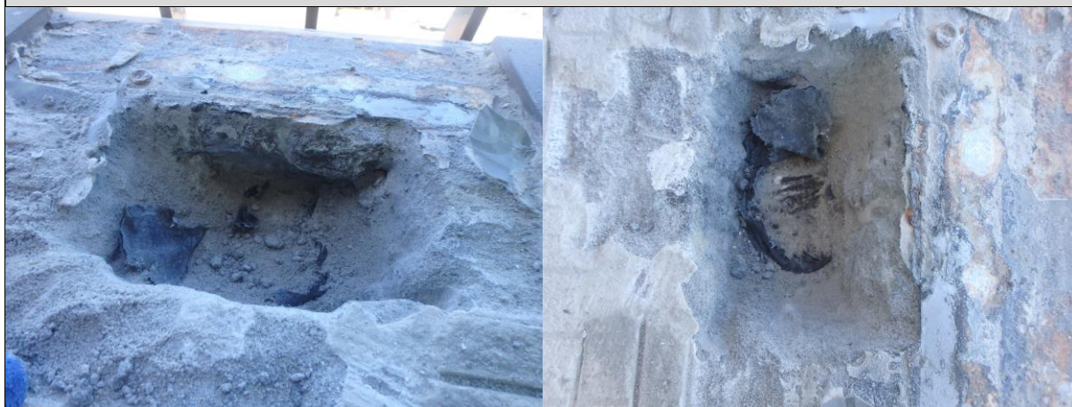
Fot. 01_24, 01_23. Pod szlichtą obecność izolacji papowej.
