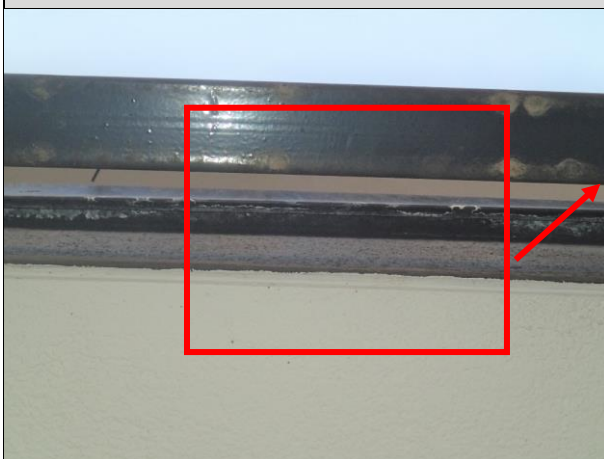
Fot. 15 . Na krawędziowych obróbkach blacharskich balkonu powyżej obserwowany miejscowo nalot węglanu wapnia świadczący o zjawisku wypłukiwania związków cementu z warstw posadzkowych.
