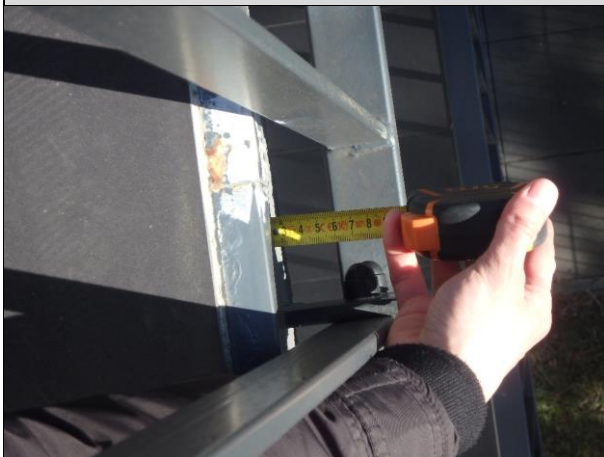
Fot. 28. Miejscowe nieprawidłowości w wielkości kapinusu obróbki blacharskiej. Tu 24mm (powinno być min 30mm)
