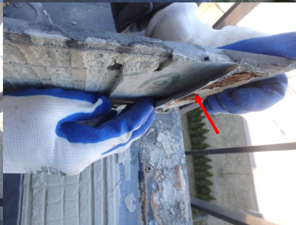
Fot. 01_4, 01_5, 01_6, 01_9. Nieprawidłowe wklejenie taśm izolacyjnych – taśma zamiast do obróbki została przyklejona do płytki – nieprawidłowo. Tak ukształtowana taśma utrudnia odpływ wody z poziomu izolacji podpłytkowej.
