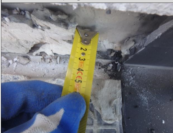
02_6. Płytką cokołową klejona na placki. Grubość placka ok 1cm .
