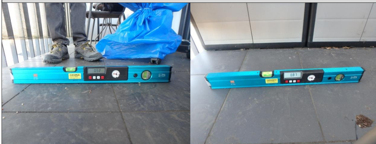
Fot. 13, 12. Zmierzona (miejscowa) wartość spadku od 0,52% do 0,87% , tj. miejscowo poniżej wartości projektowanej w wymiarze 1% .
