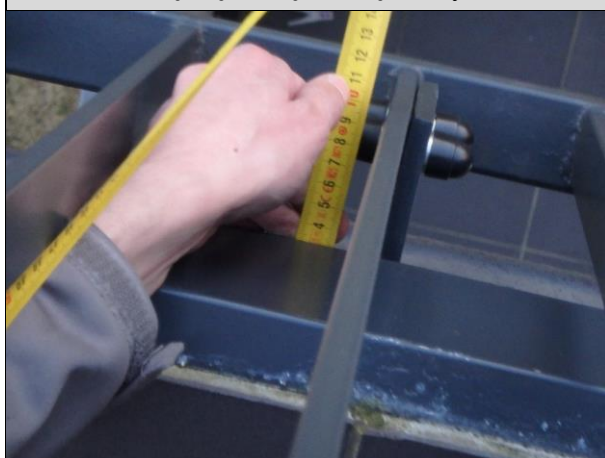
Fot. 19. Zmierzona wartość okapu obróbki blacharskiej 33mm – prawidłowo.
