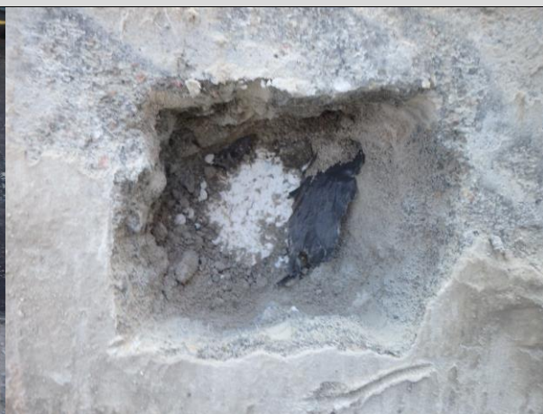
Fot. 04_9. Pod szlichtą obecność folii PE oraz styropianu.
