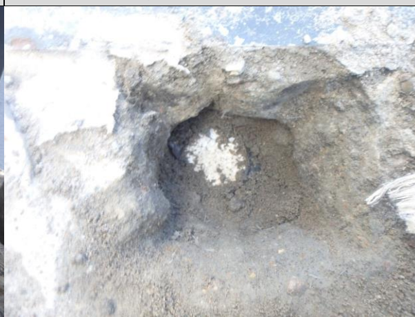
Fot. 03_13. Pod szlichtą obecność folii PE oraz styropianu.
