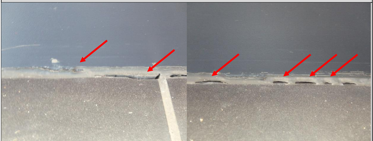
Fot. 28, 29. Miejscowe ubytki uszczelniacza poliuretanowego w miejscu styku ościeżnicy drzwiowej z okładziną ceramiczną.
