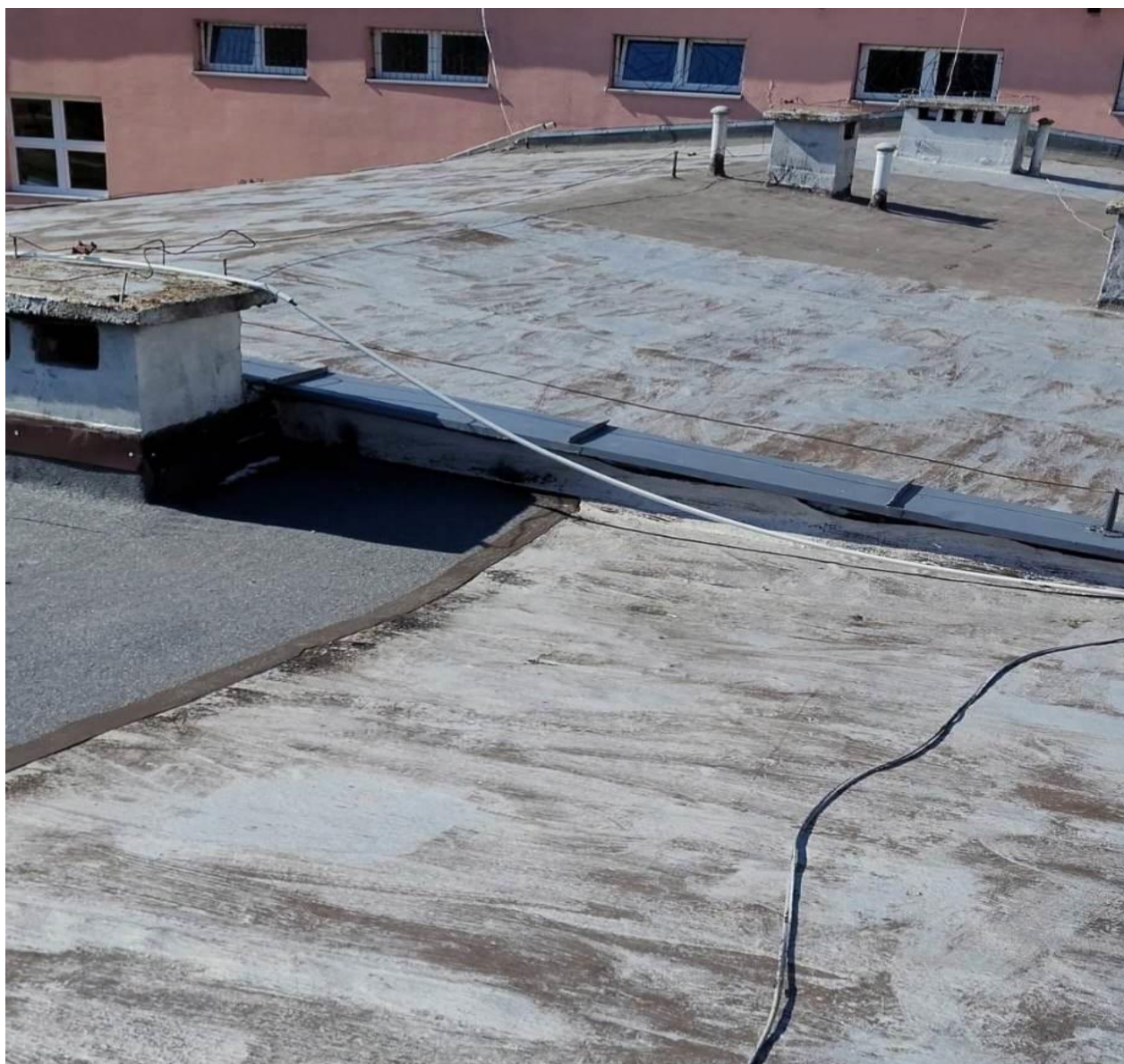
Foto-Projektant - Widok na dach nad częścią B
