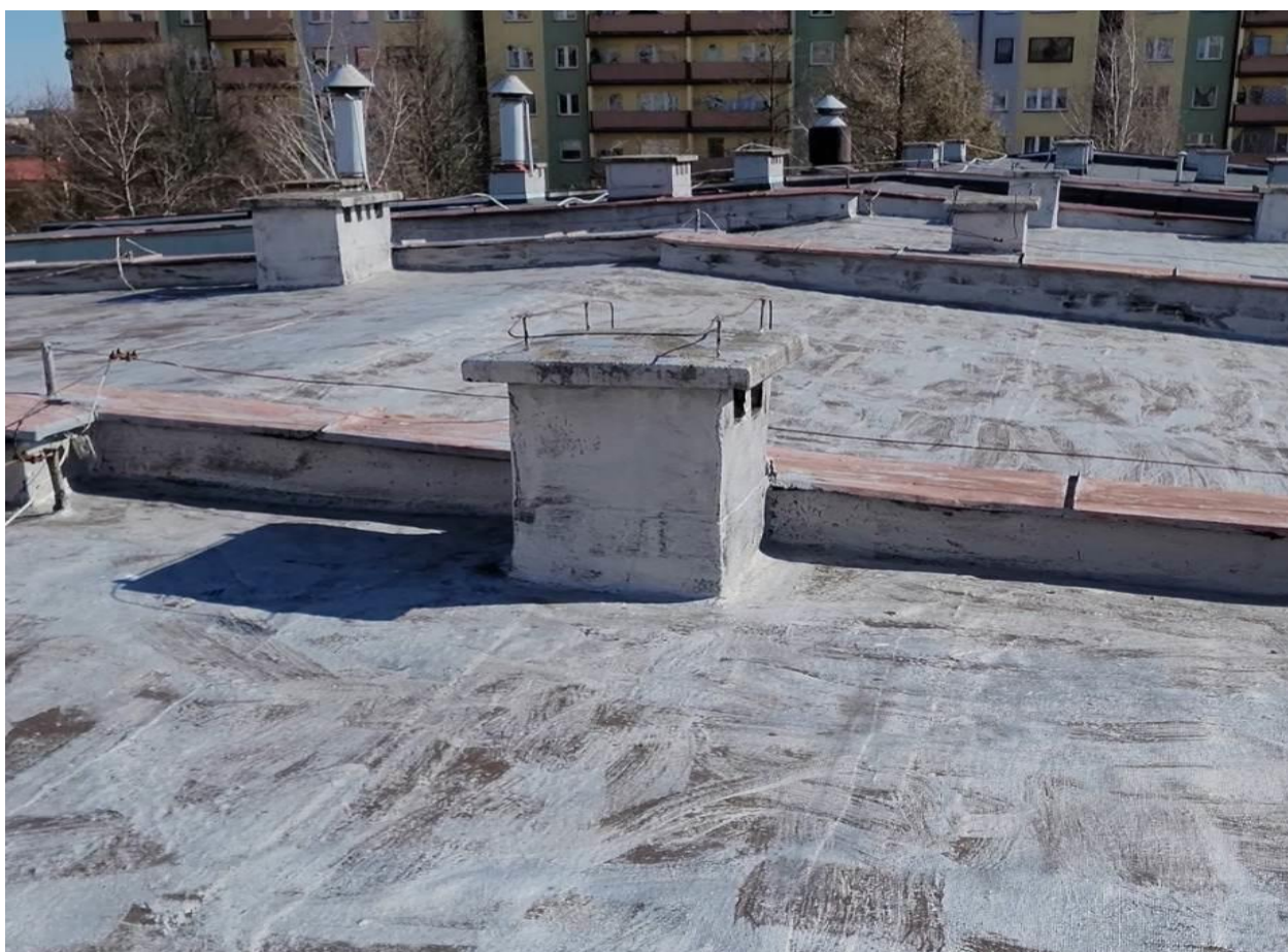
Foto-Projektant - Widok na dach nad częścią
