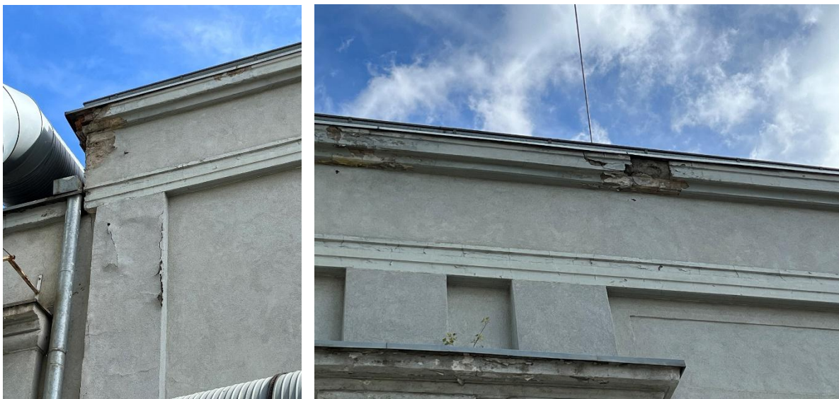
Rysunek 12. Widoczne uszkodzenia elementów niemających znaczenia konstrukcyjnego na zewnątrz budynku
