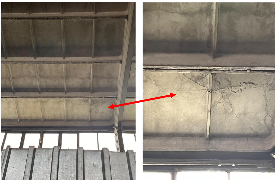
Rysunek 26. Uszkodzona płyta dachowa G
