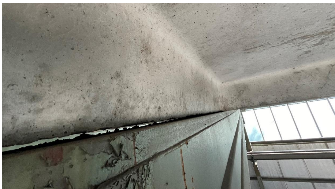
Rysunek 30. Oparcie płyty dachowej żelbetowej na ryglu ramy
