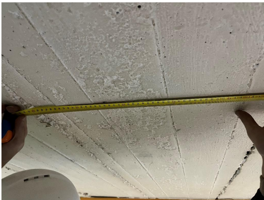
Rysunek 8. Pomiar szerokości płyty dachowej, celem jej identyfikacji
