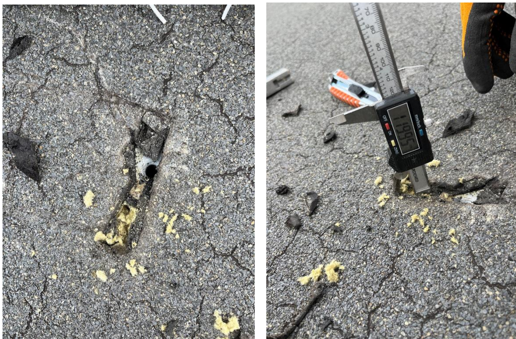
Rysunek 11. Odkrywka dachu mająca na celu określenie grubości izolacji termicznej oraz liczby warstw papy w części socjalno-biurowej
