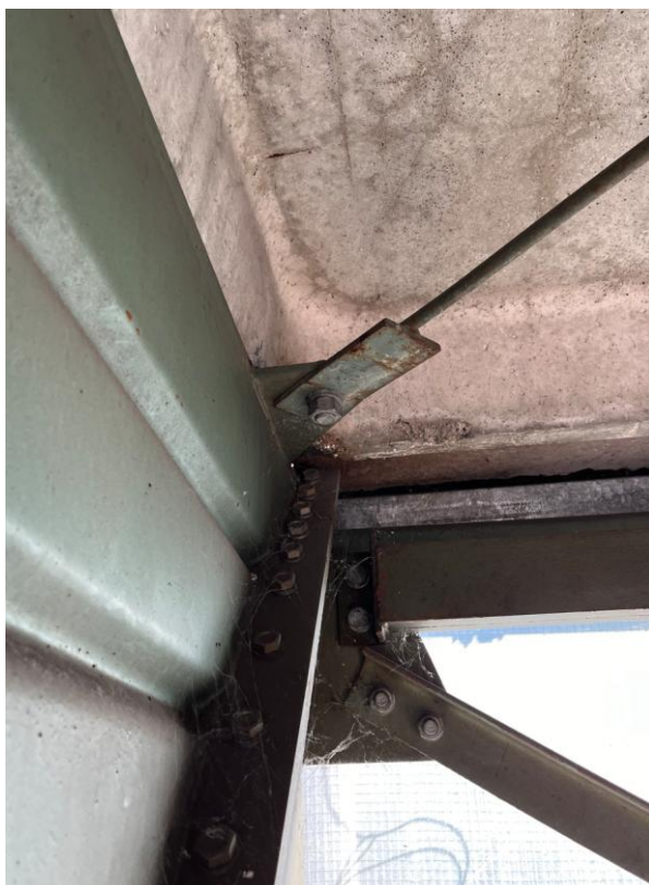
Rysunek 18. Węzeł narożny wraz ze stężeniami
