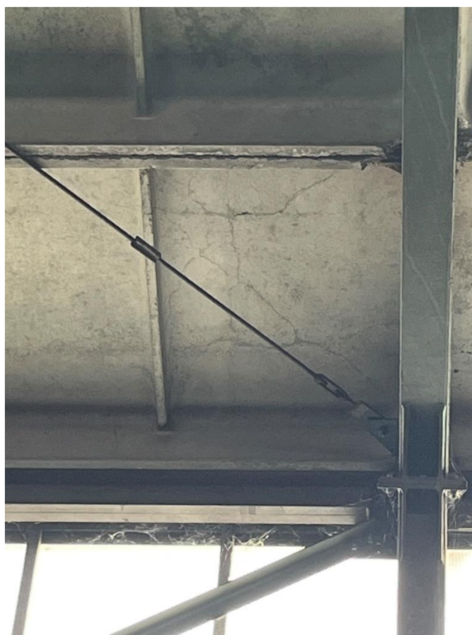
Rysunek 27. Uszkodzona płyta dachowa H
