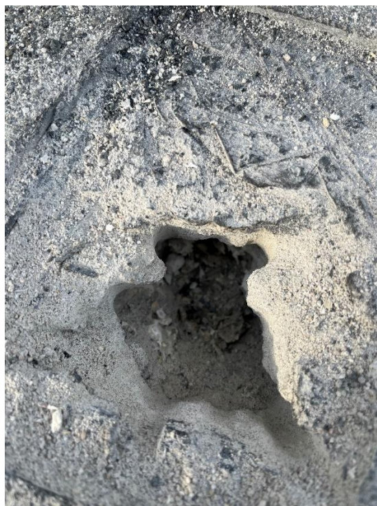
Rysunek 32. Odkrywka w dachu, celem sprawdzenia grubości warstw
