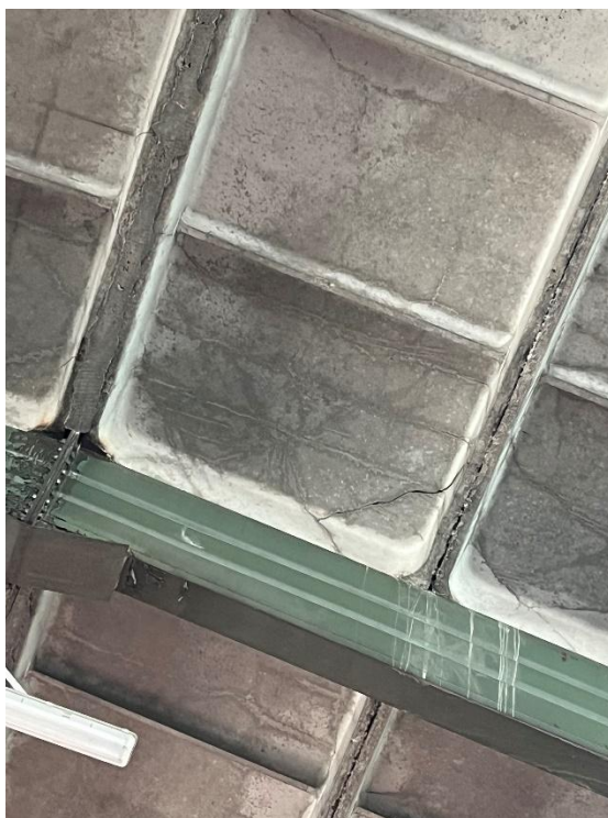
Rysunek 20. Uszkodzona płyta dachowa A
