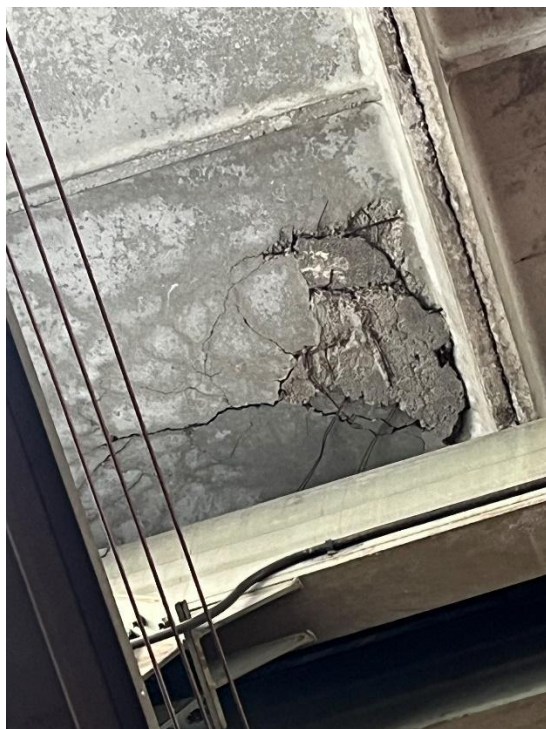
Rysunek 21. Uszkodzona płyta dachowa B
