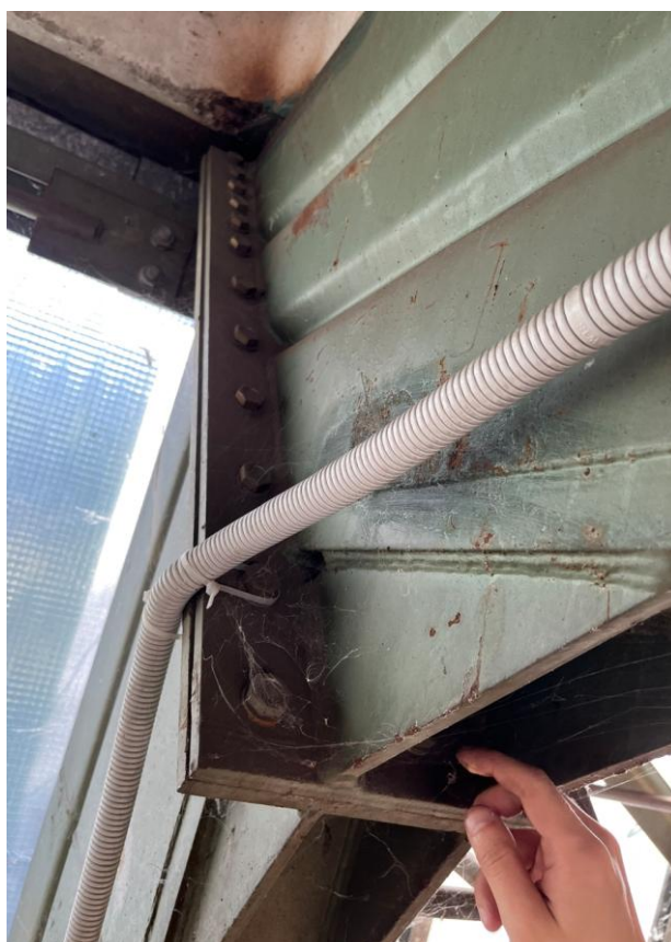
Rysunek 17. Połączenie sztywne narożnika ramy
