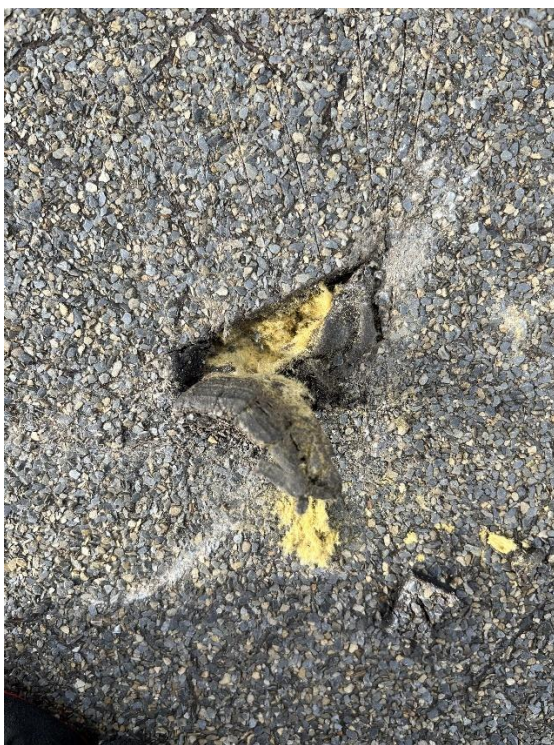
Rysunek 9. Odkrywka w dachu mająca na celu określenie grubości izolacji termicznej oraz liczby warstw papy w części hali produkcyjnej.
