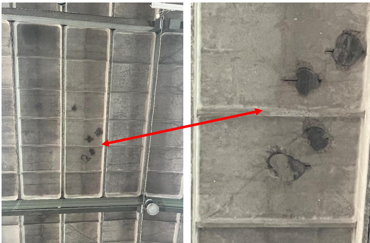
Rysunek 24. Uszkodzona płyta dachowa E
