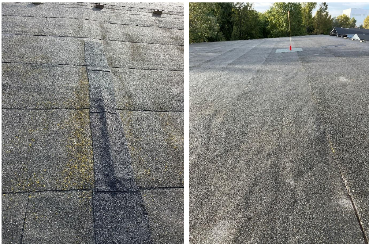
Rysunek 31. Lokalne odkształcenia papy na powierzchni dachu
