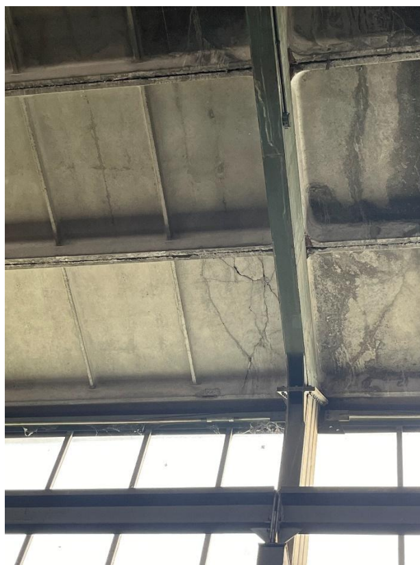
Rysunek 25. Uszkodzona płyta dachowa F
