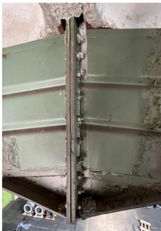
Rysunek 16. Połączenie sztywne w środku rozpiętości rygla
