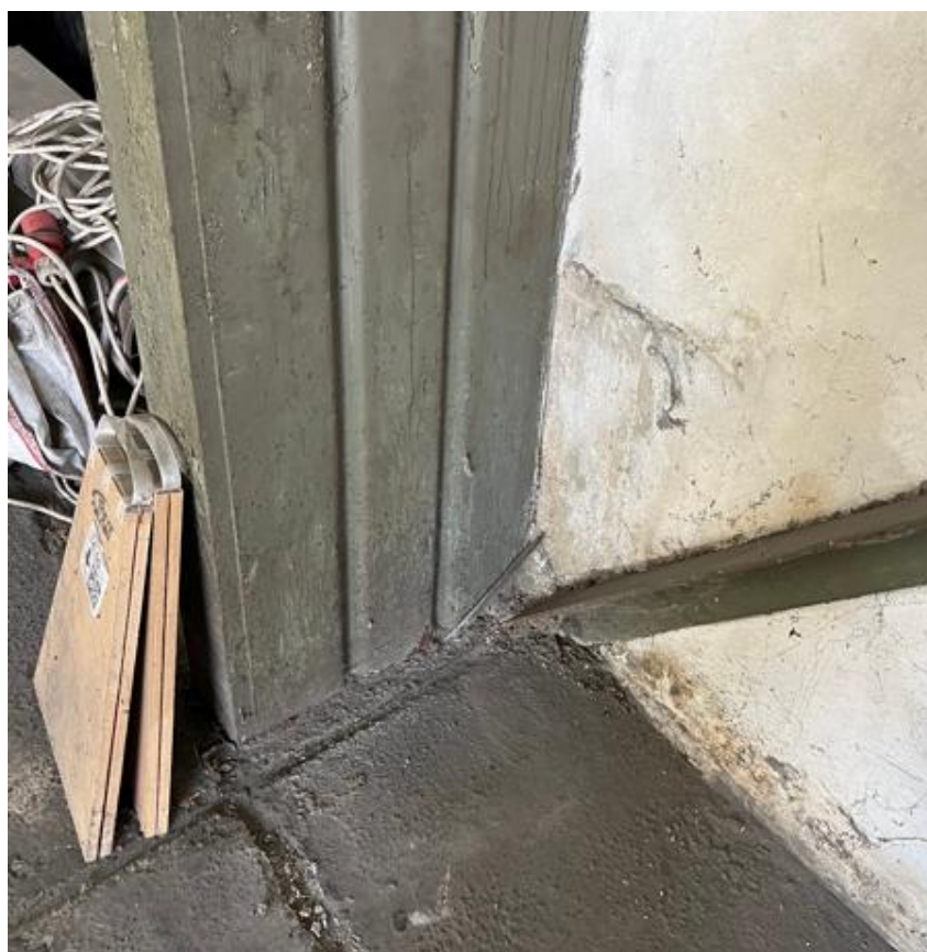
Rysunek 15. Utwierdzenie słupa ramy w fundamencie
