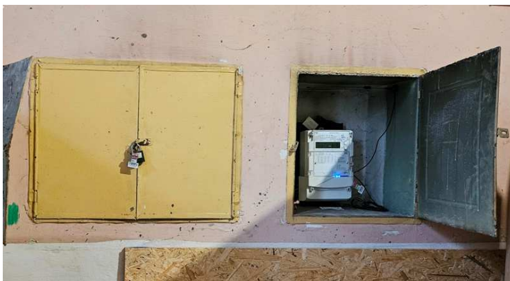
Istniejąca rozdzielnia główna TGL w budynku oraz istniejący licznik energii elektrycznej - licznik nr: 55 882 891
