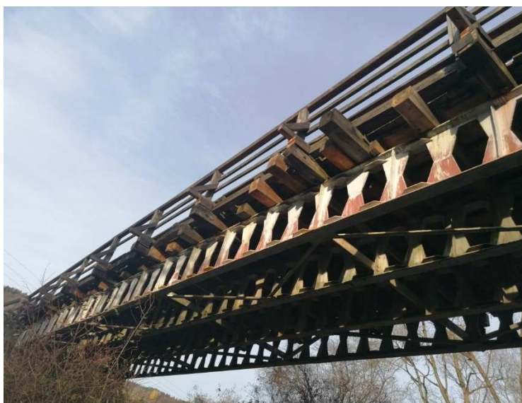
Widok konstrukcji nośnej od dołu
