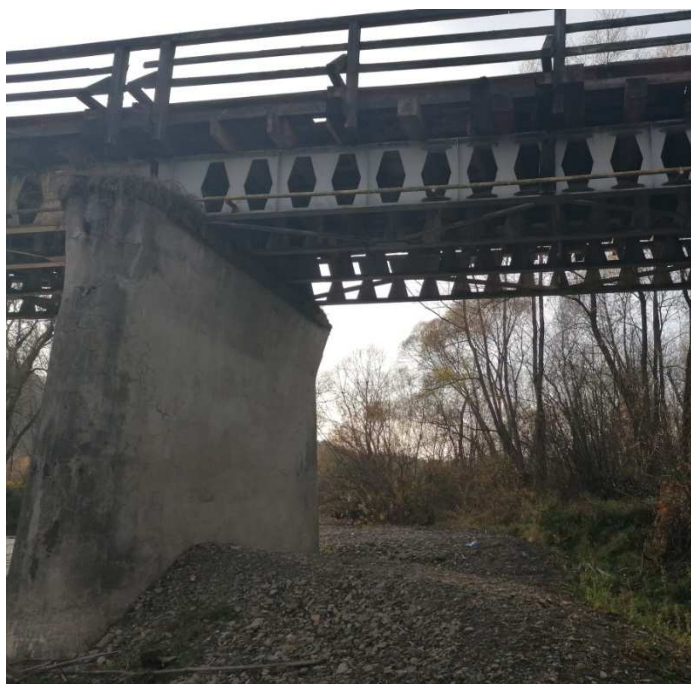
Widok ogólny podpory pośredniej.
