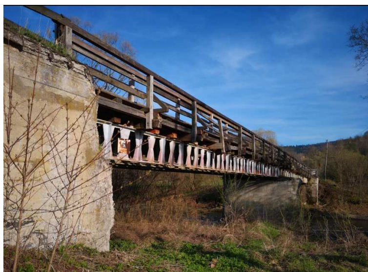
Widok ogólny elewacji mostu od strony górnej wody
