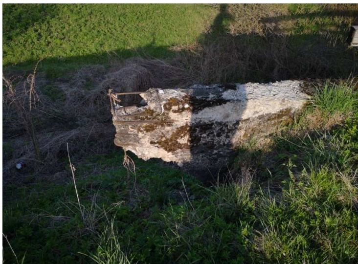
Widok od strony jezdni odsłoniętej końcówki skrzydła.
