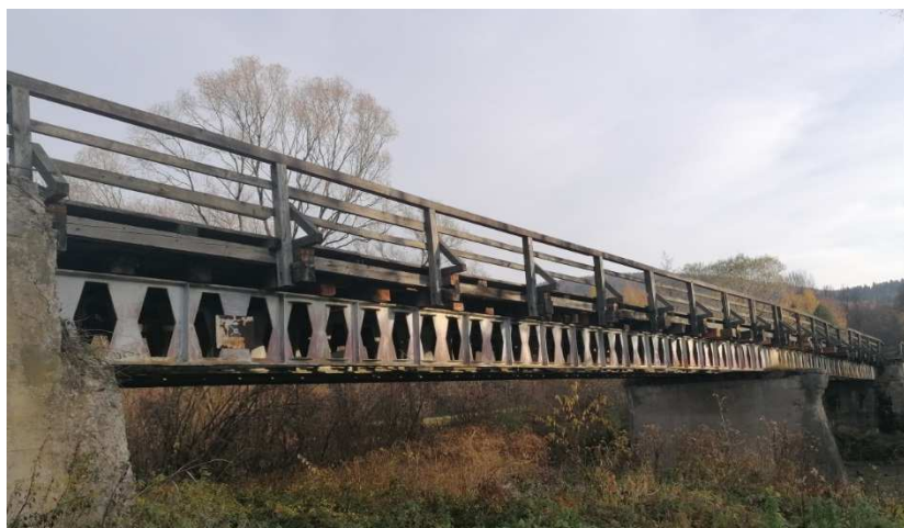
Widok z boku konstrukcji stalowej pomostu.
