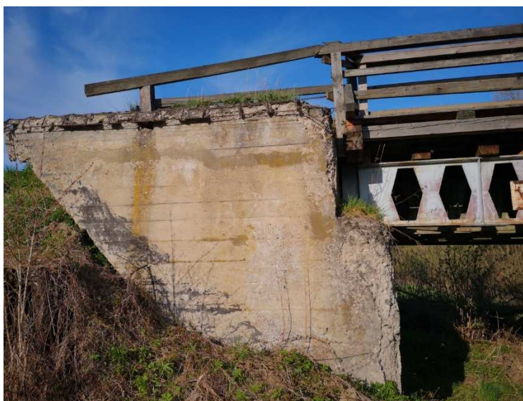
Widok przyczółka lewobrzeżnego od strony górnej wody
