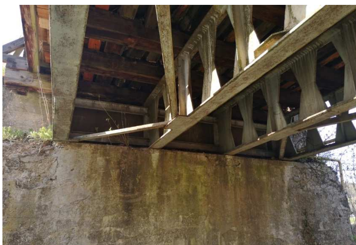
Oparcie belek ustroju nośnego na podporze skrajnej
