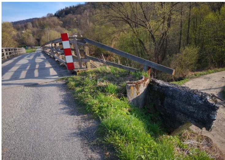
Widok od strony jezdni odsłoniętej końcówki skrzydła. Uwagi jw.
