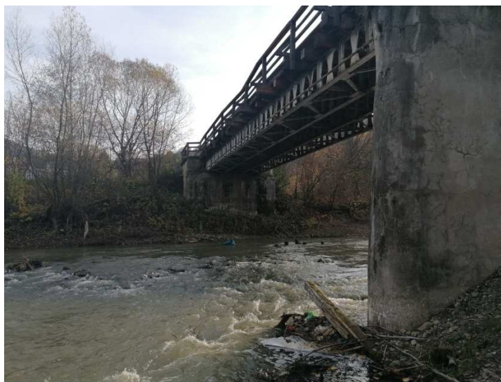
Widok na koryto rzeki Ropa – widoczny główny nurt rzeki pomiędzy przyczółkiem prawobrzeżnym i podporą pośrednią
